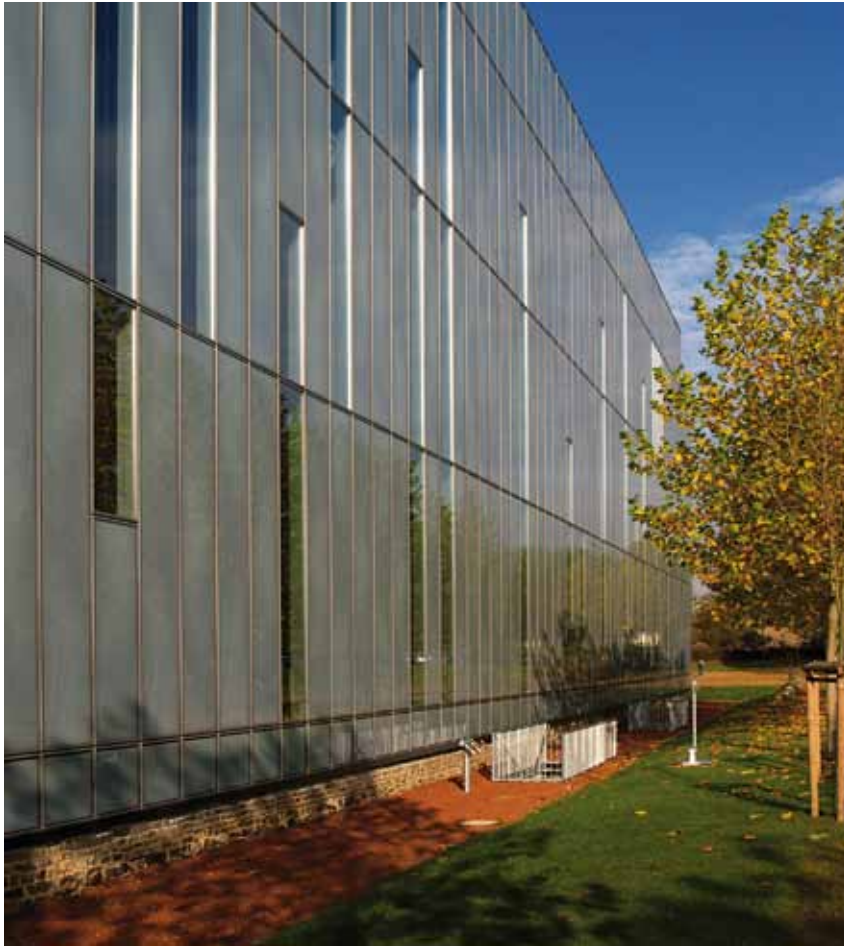
Durch ein auf die Verglasung gedrucktes, geometrisches Ornament des Künstlers Thomas Weile wird dem Betrachter eine räumliche Tiefe der Fassade suggeriert.
