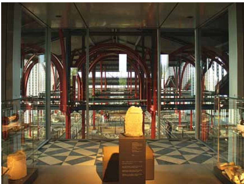
Die Ausstellung im Innenraum ist zum großen Teil auf frei im Raum abgehängten Rampen und Ebenen untergebracht.
