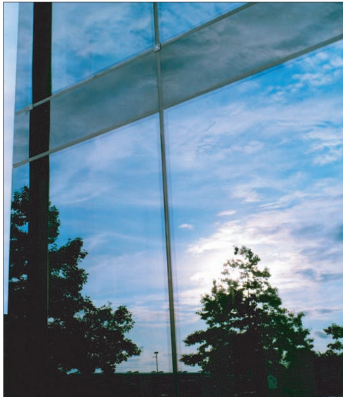
Durchgängige Glasfelder mit schmalen Silikonfugen vereinen die harmonische homogene Optik der Fassade mit reizvollen Spiegelungen und stets neuen optischen Effekten.
